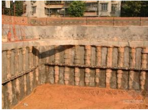
基坑支护示例图
