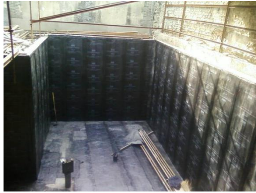
基坑卷材防水示例图
