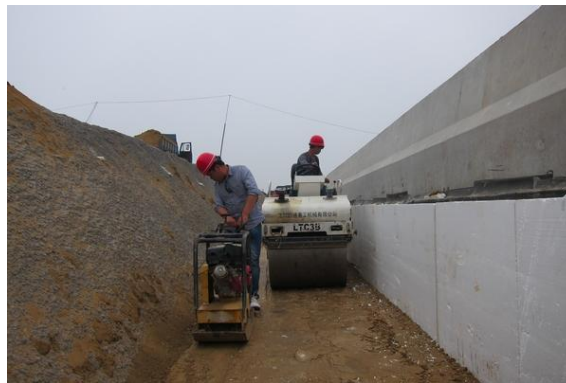
石粉回填碾压示例图
