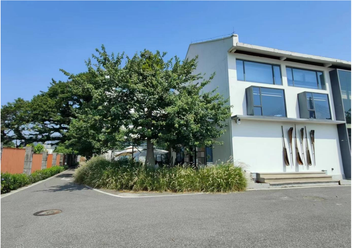
图2-16 北濠水闸左岸海尚明珠智慧园现状建筑及园区围墙（本次新建泵站进水段）
