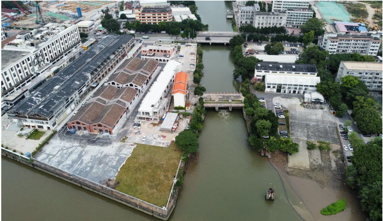
图5-36 北濠涌泵站拟建工程位置俯瞰图
