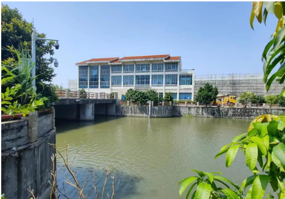
图2-8 北濠水闸内涌侧右岸现状图
