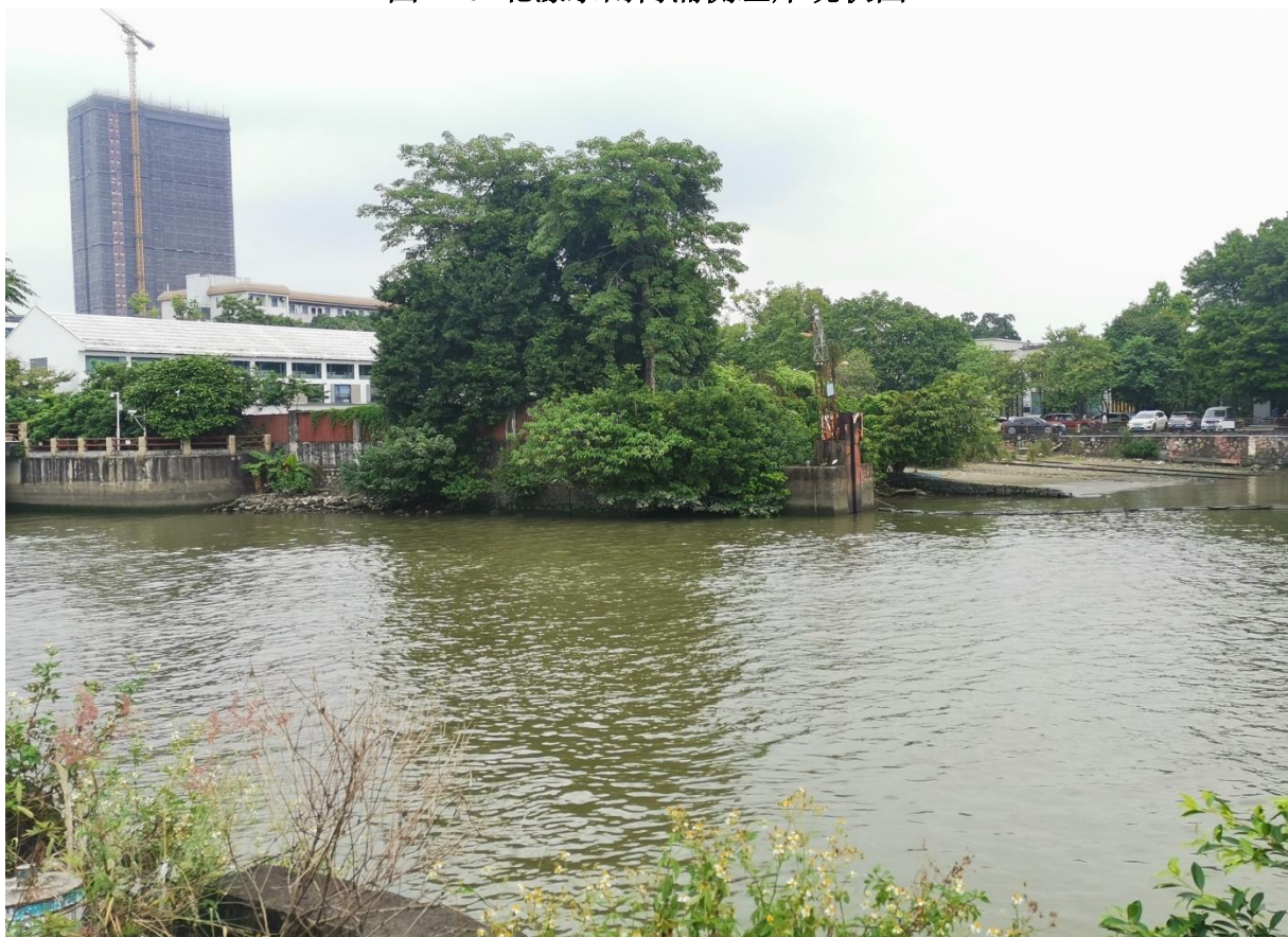
图2-11 北濠水闸外江侧左岸现状图
