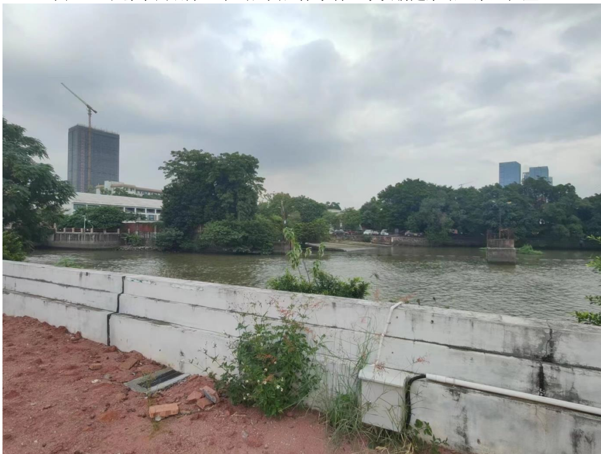
图2-15 北濠水闸右岸外江侧珠江堤防
