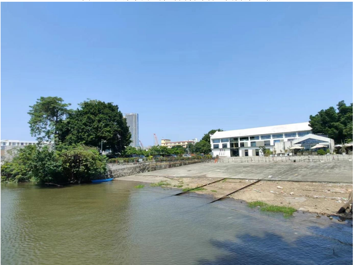
图2-19 北濠水闸左岸外江测船舶下水滑道
