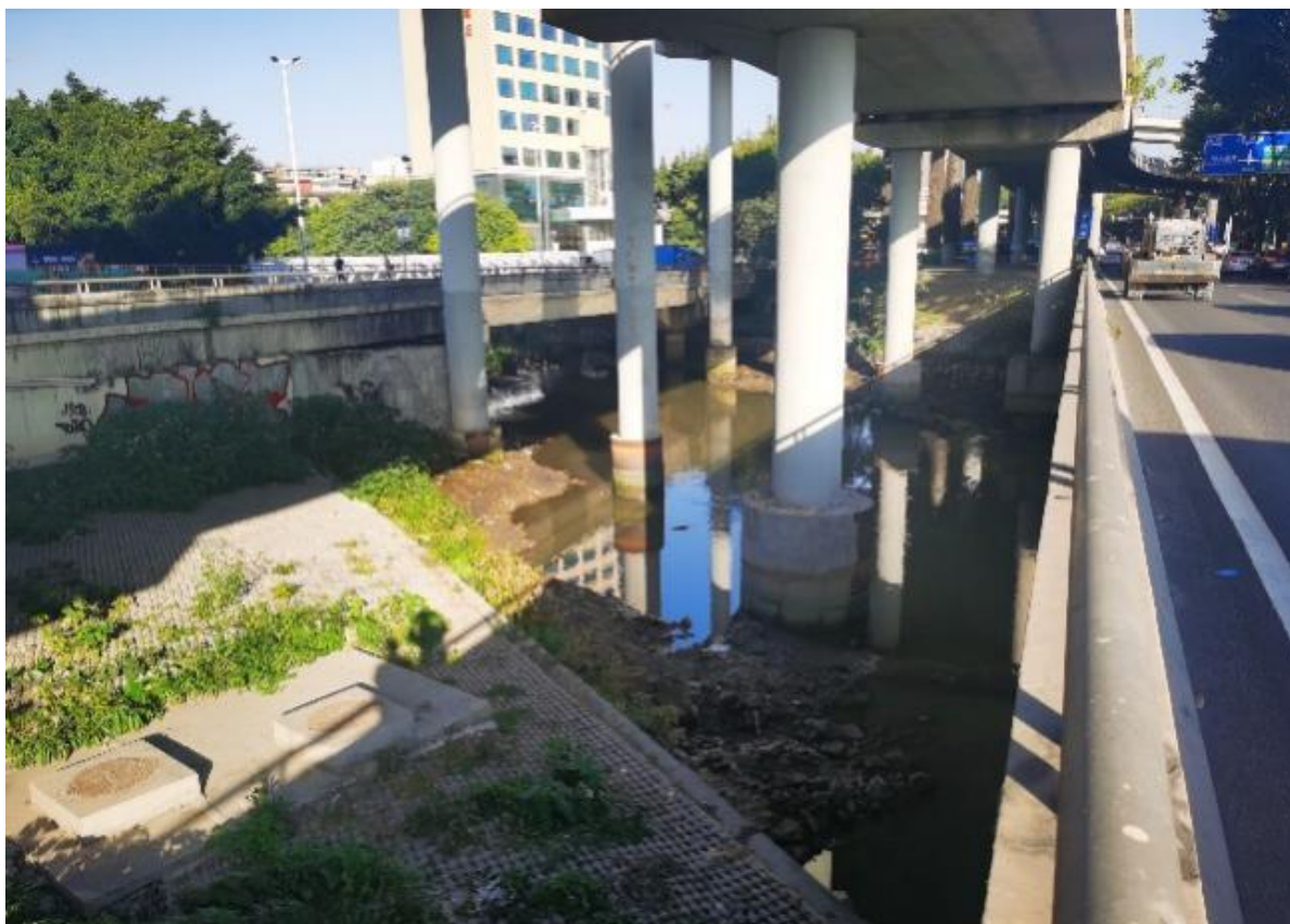
图5-26 南洲路桥情况
