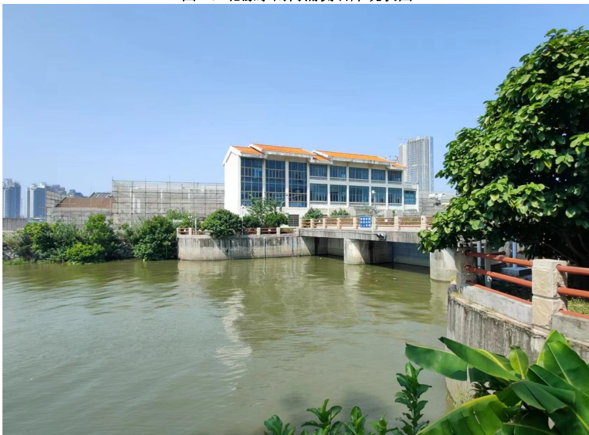
图2-9 北濠水闸外江侧右岸现状图
