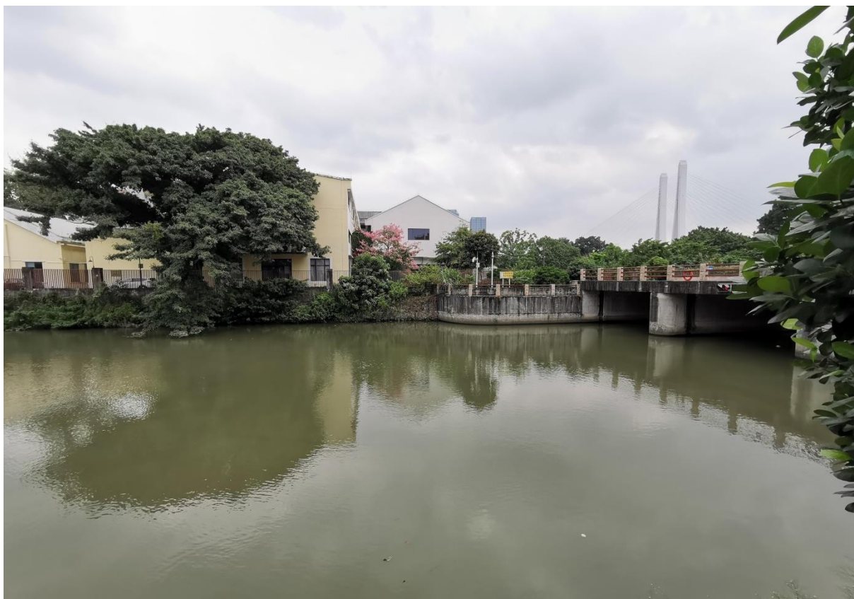
图2-10 北濠水闸内涌侧左岸现状图
