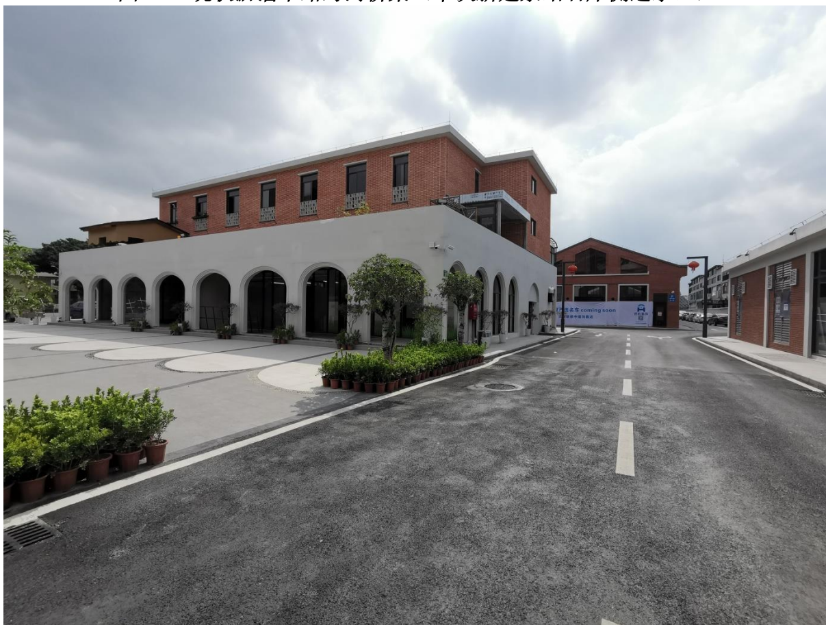
图2-13 北濠水闸右岸思维创汇园区建筑及道路
