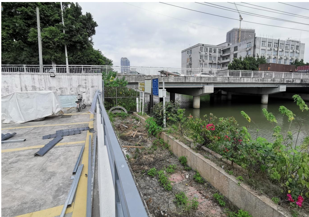
图2-12 现状沥滘中路跨河桥梁（本次新建泵站右岸侧进水口）
