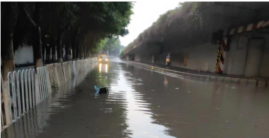
图4-7 2023年6月1~4日瑞宝片区水浸现场
