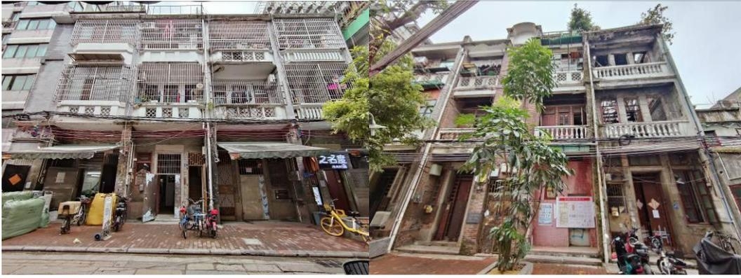
建筑外立面破损老旧、“三线”架空敷设杂乱现象
