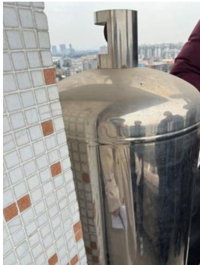
图 3.1-19 升平大厦天面加压泵图
