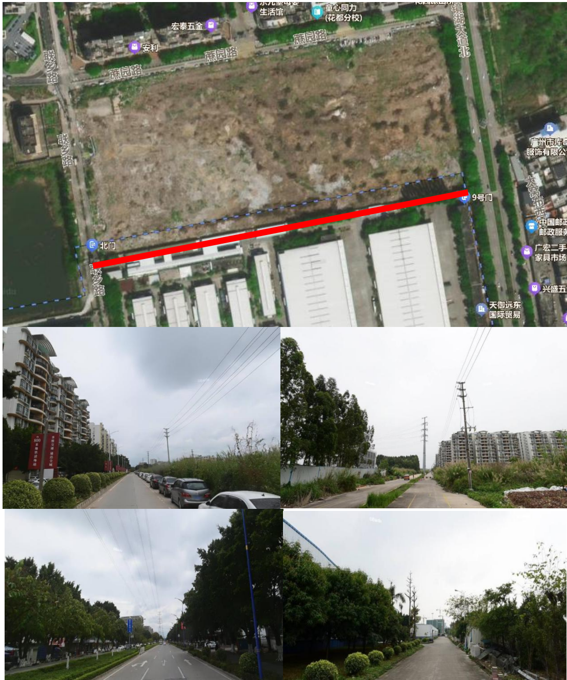
图 4-3-3 区域现状情况
