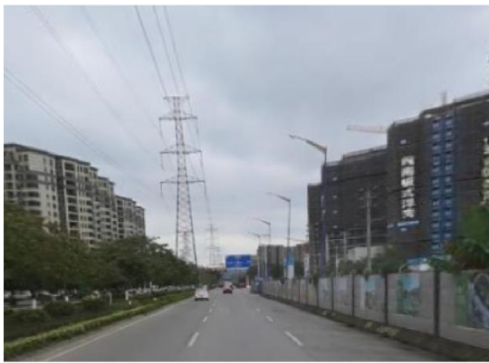
道路中央绿化带高压架空电缆
