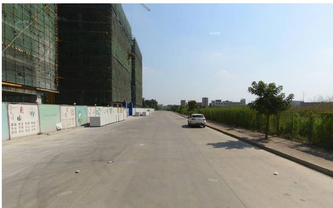
图 3-3-4 穗达路现状（未建设路灯，本次改造需新增路灯）
