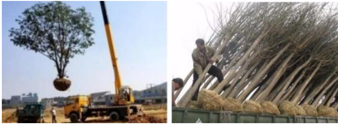
图 13-13 树木吊运装车示意图
