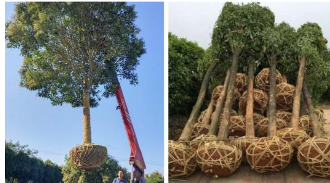
图 13-12 树木吊运装车示意图
