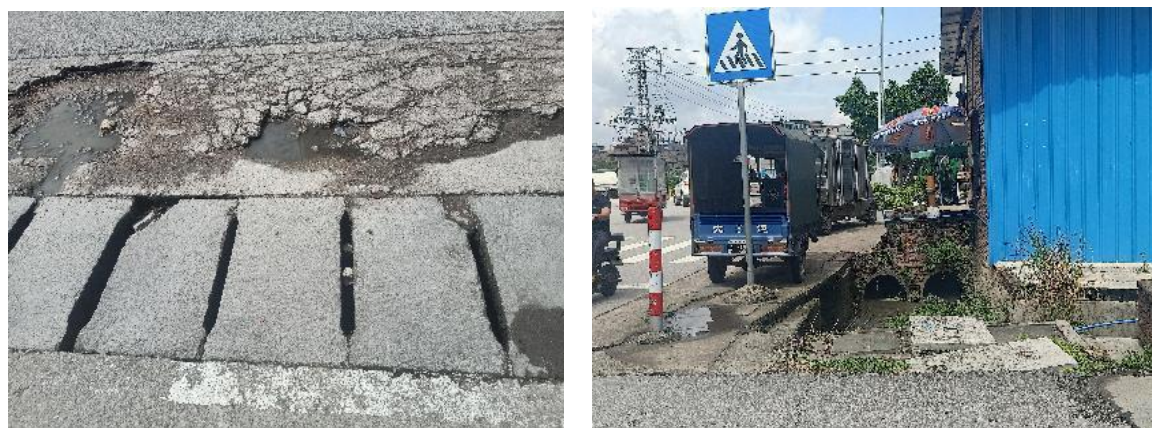
图 3-2 沿途排水渠现状图
