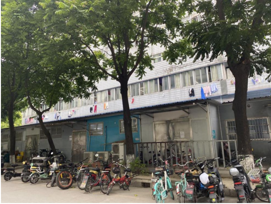
图 4-2-2 内科楼室外活动房实景图（本次拟拆除室外活动房）
