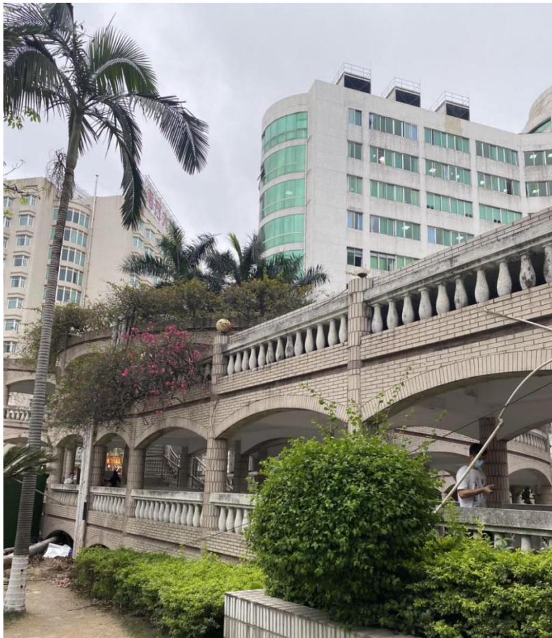
图 4-2-3 场地旁边连廊（本次拟进行拆除）
