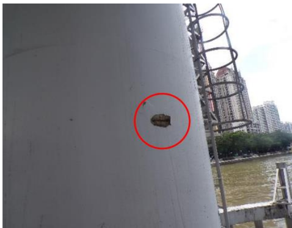
图 2.38 19-2#墩锈胀露筋
