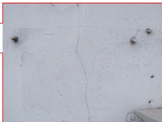
图 2.37 19-1#柱竖向裂缝
