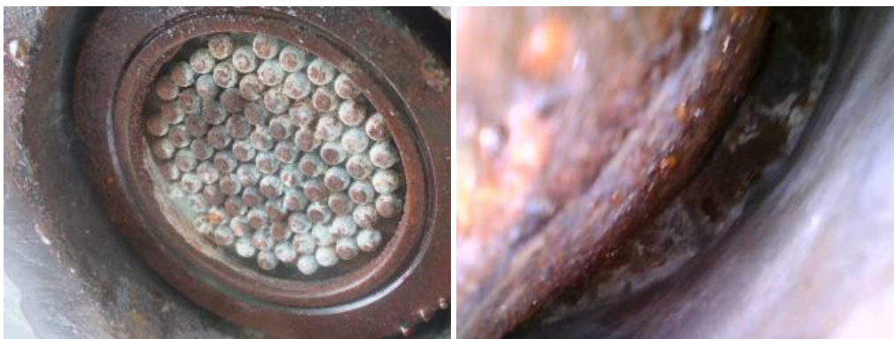
图 5.3 部分吊杆下锚锚头现状
