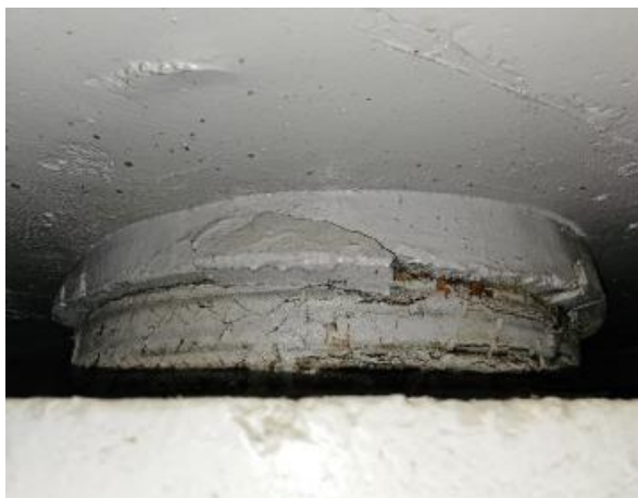
图 2.70 4-1#支座中度老化
