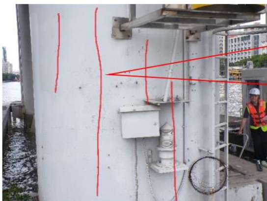
图 2.37 19-1#柱竖向裂缝
