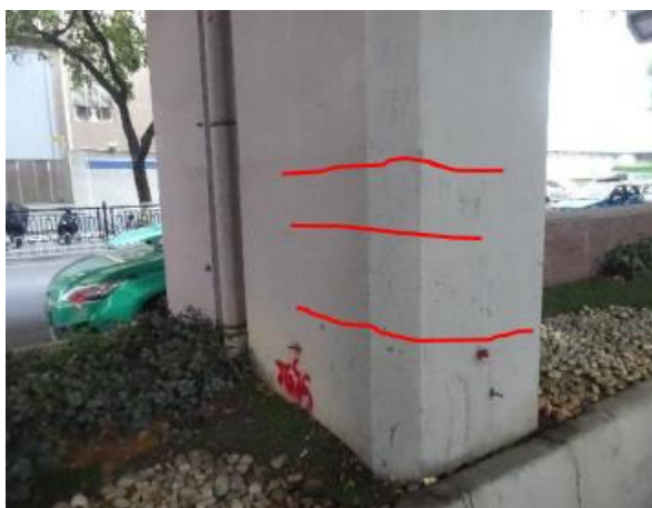
图 2.63 7#墩环向裂缝
