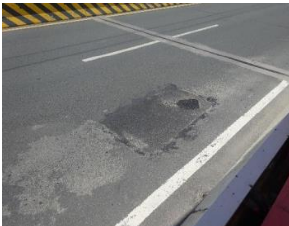
图 2.15 桥面铺装破损修补状况良好
