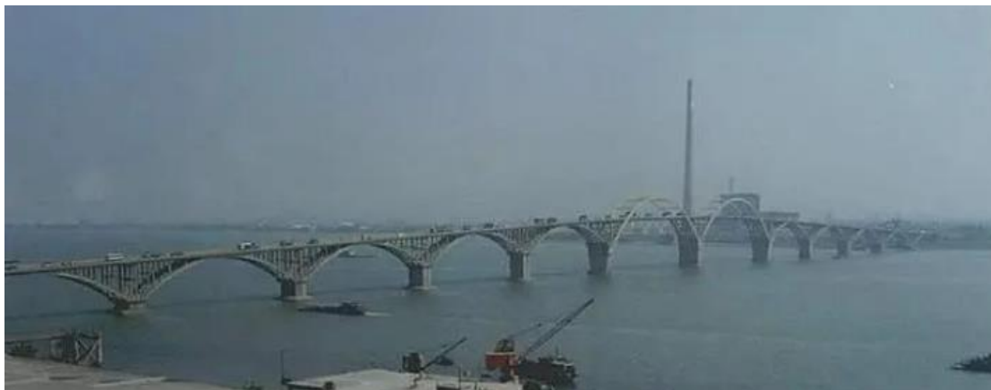
图 2.80 高明大桥旧桥
