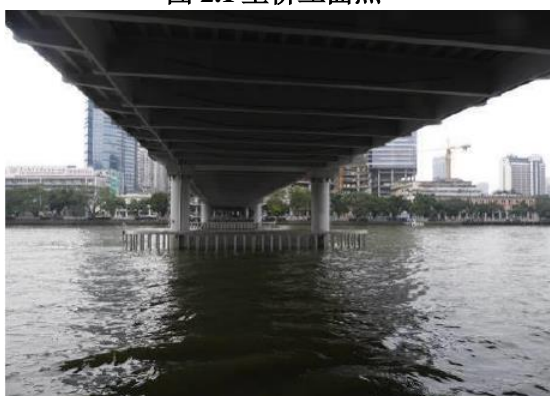
图 2.3 主桥桥底状况照图
