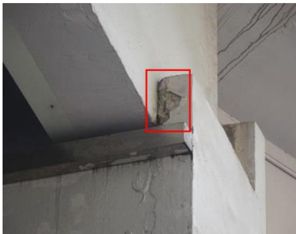
图 2.52 1#盖梁砼剥落
