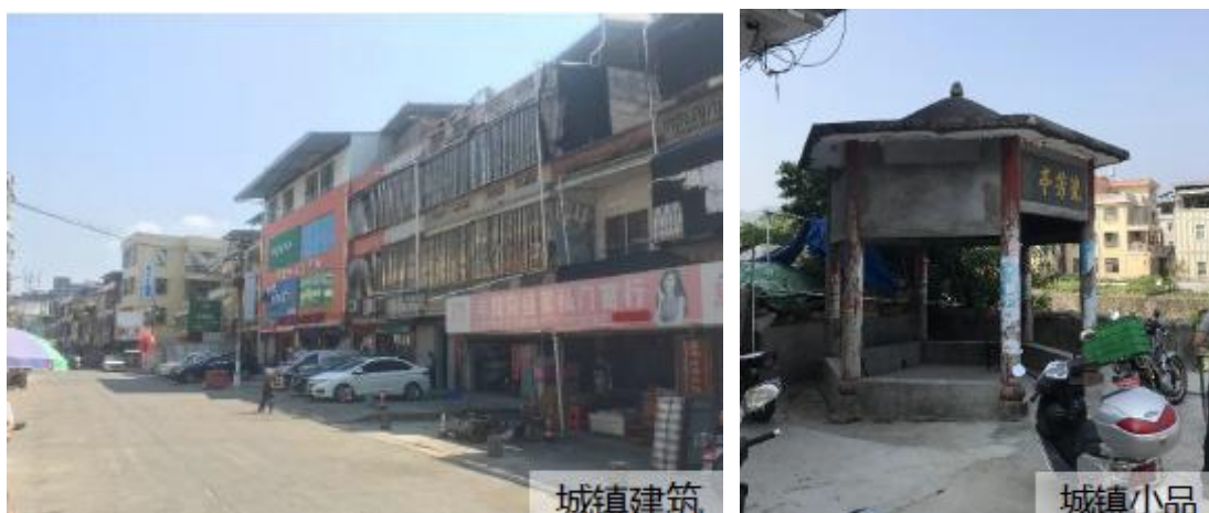
图 3-5 城镇风貌现状照片
