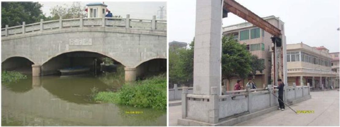
庙头涌 1 号水闸（左）、庙头涌 2 号水闸（右）现状图
