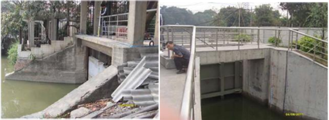
庙头涌东闸（左）、南湾涌东闸（右）现状图
