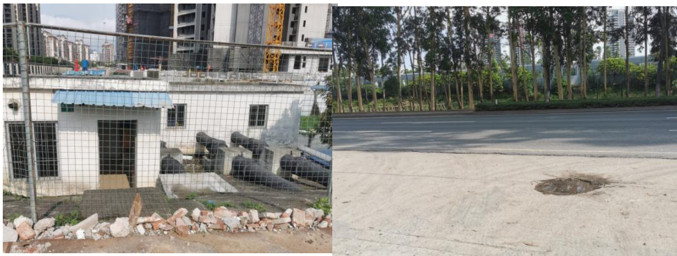
图 3-3 现状管线照片
