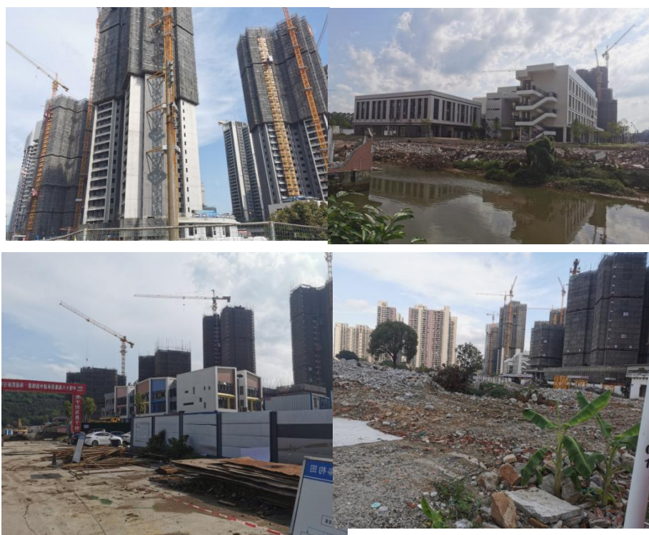
图 3-4 地块现状照片
