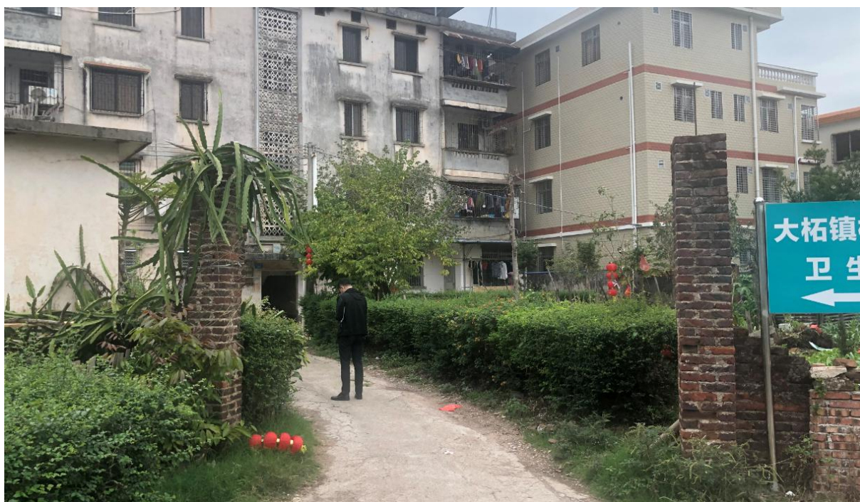
图 5-3 部分小区场地现状 (3)
