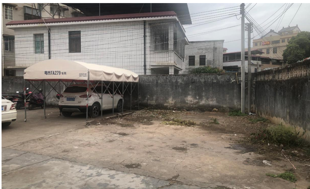
图 5-1 部分小区场地现状（1）
