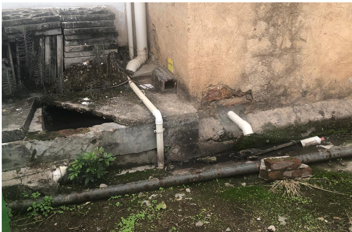
图 5-2 部分小区场地现状 (2)
