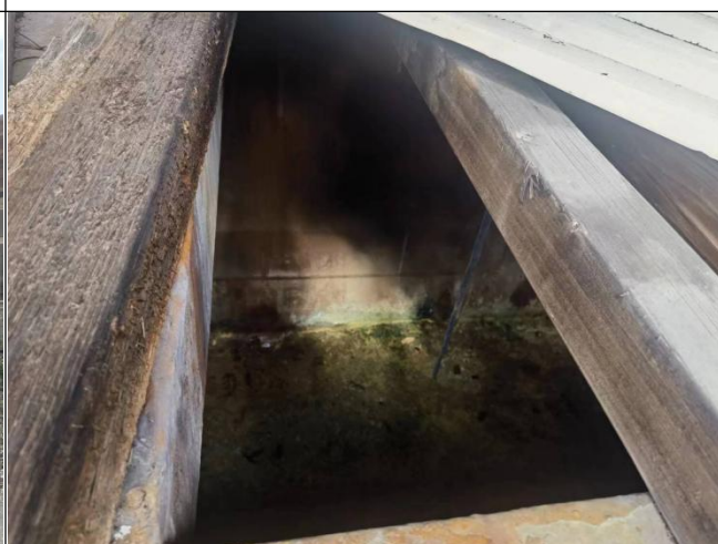
地上废水处理设备
