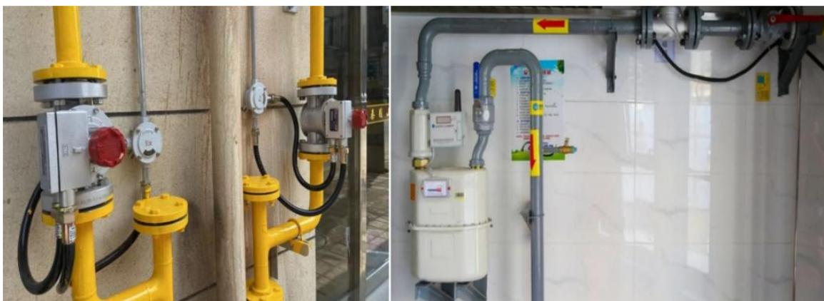
图 4-27 燃气管示意图
