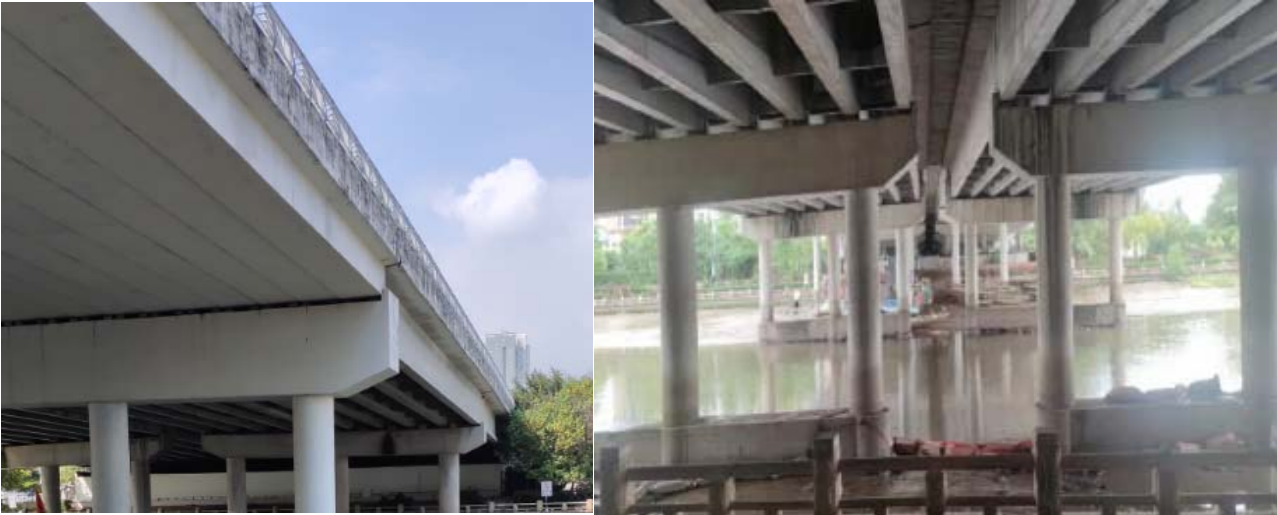
照片 1.8 黄埔涌大桥桥底照（空心板）照片 1.9 黄埔涌大桥桥底照（T 梁）
