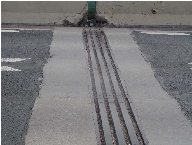
图4.5 左侧防撞墙内侧破损露筋
