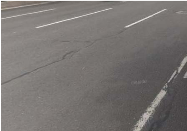
图 2.1-2 路面纵向裂缝
