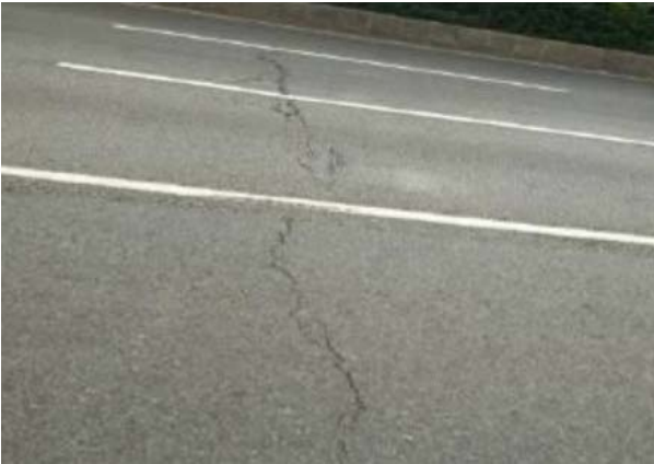
图 2.1-1 路面横向裂缝
