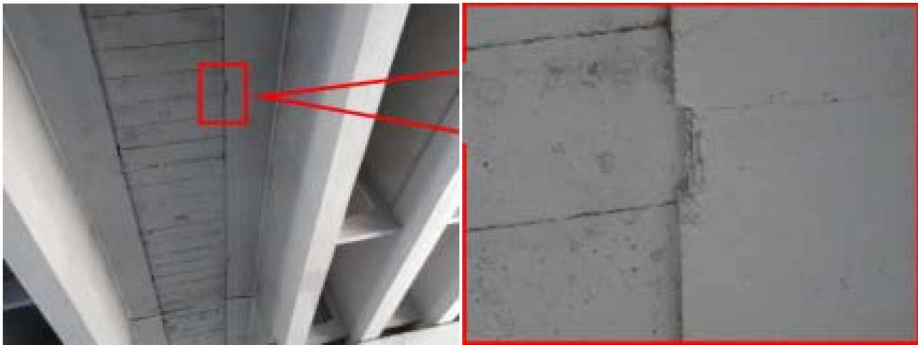
图4.1 梁右翼板砼破损露筋整体照
