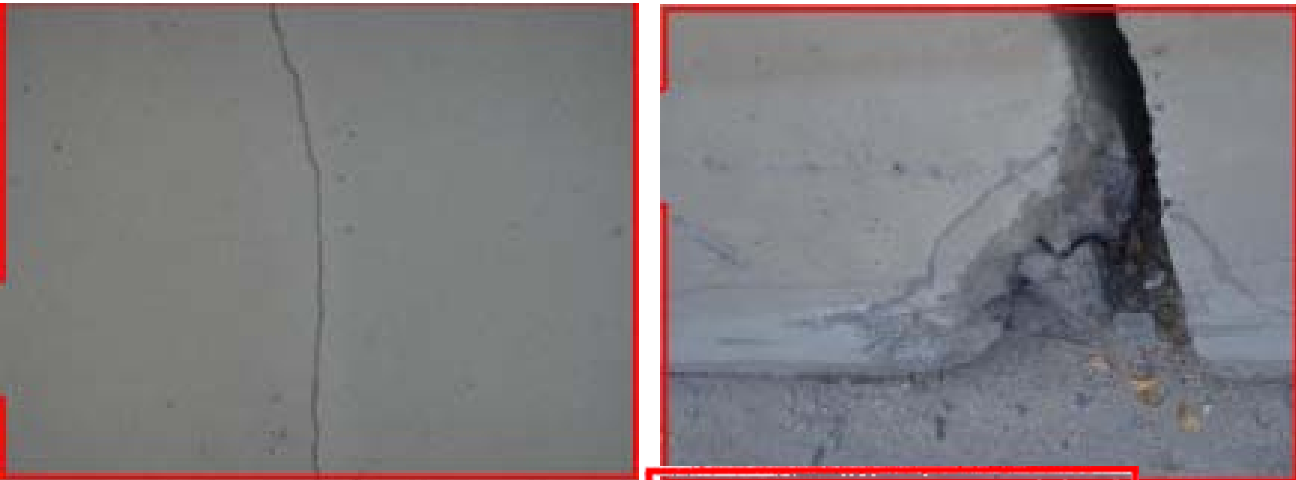
图4.3引道挡墙竖向裂缝
