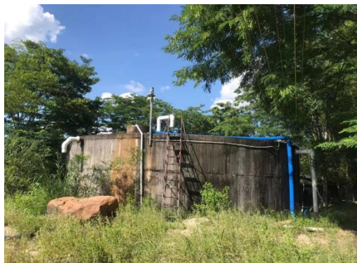
鸿鑫水厂清水池
