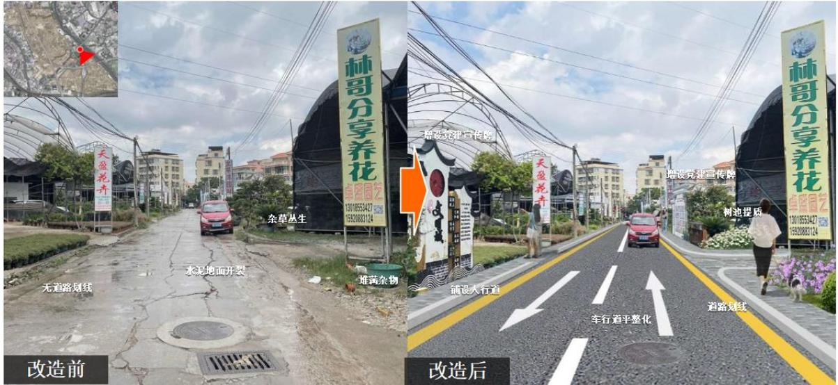
图 5-44 连新路路面改造效果图
