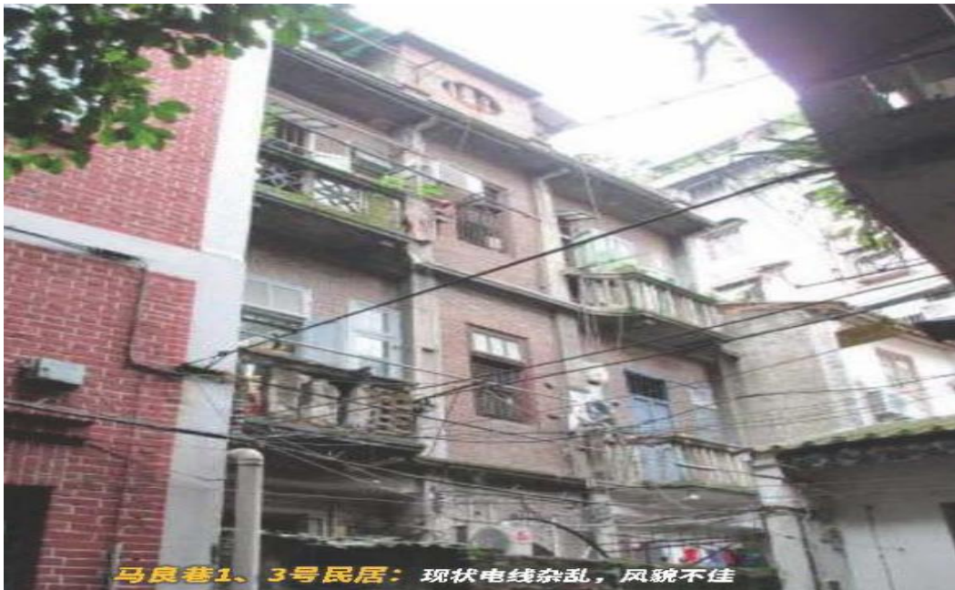
图 3-1-13 街边建筑现状
