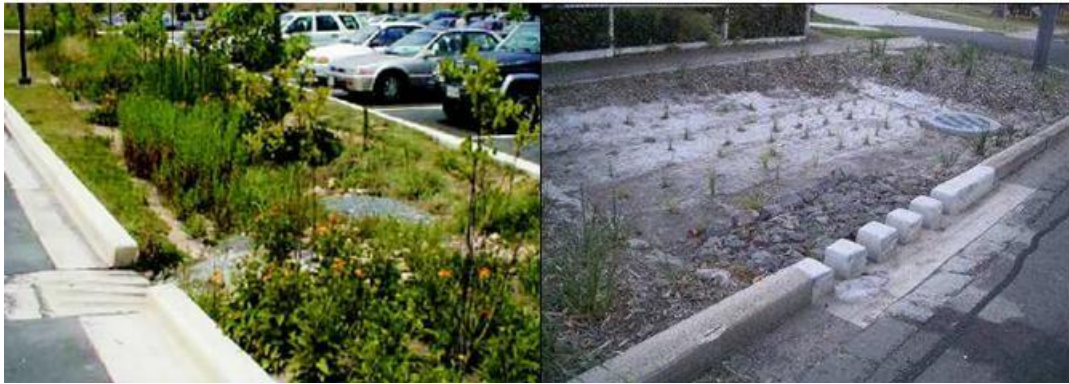
图 11.6-4 生物滞留设施示意图
