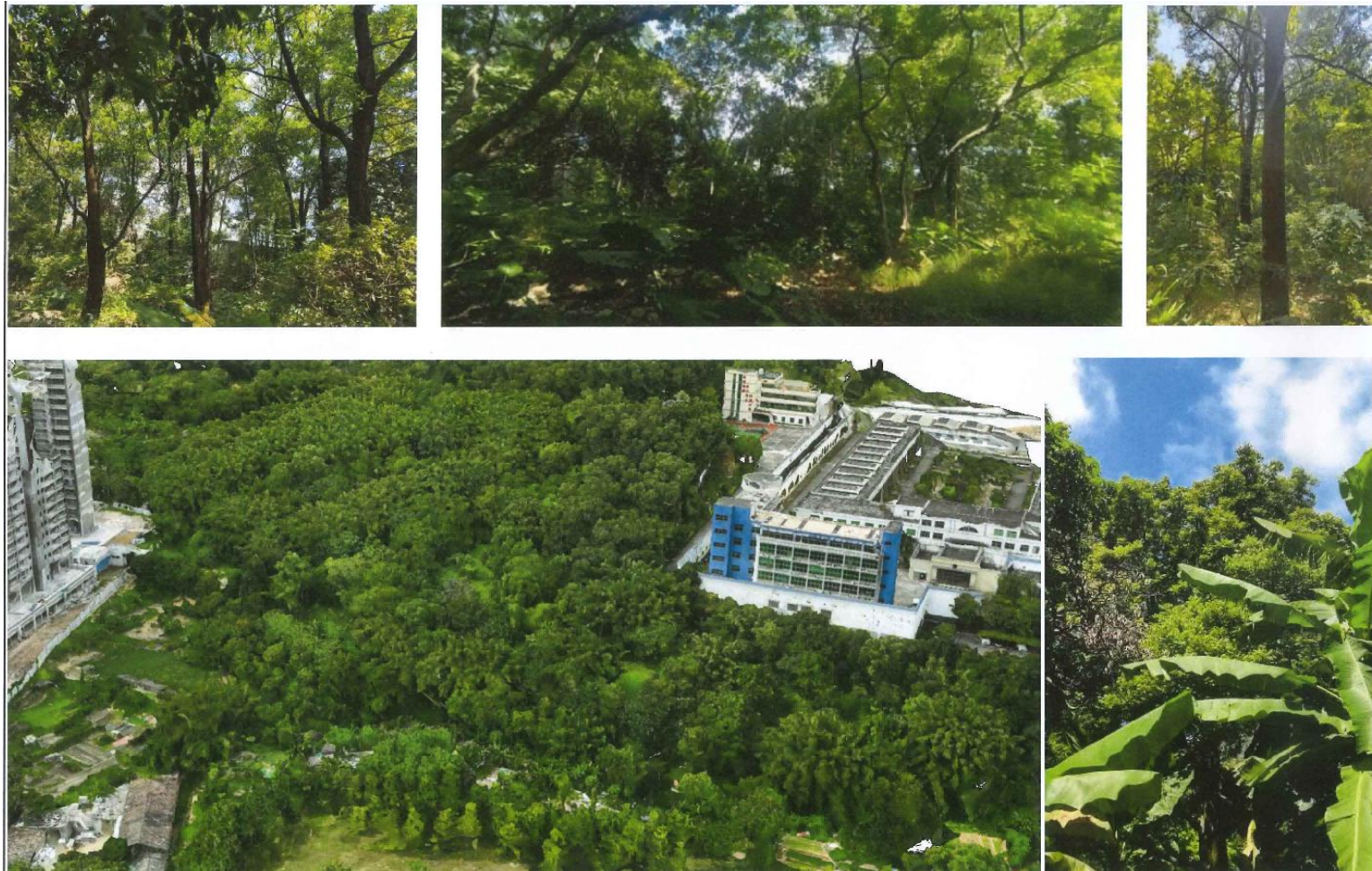
图 4.1-5 项目地块航拍及内部实拍图
