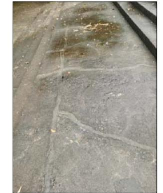
照片3 坡顶平台裂缝
