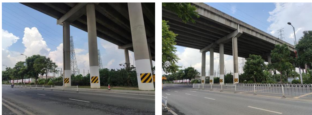
图 5-16 下横沥大桥现状图
