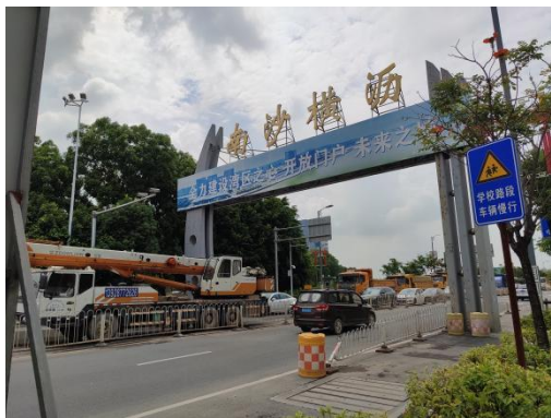
图 5-8 入口牌坊现状 1
