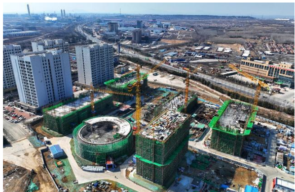
临港商务区一期建设工程项目现场
