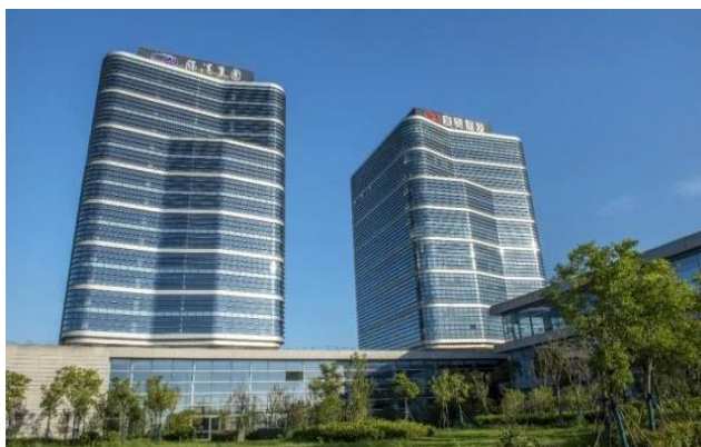
洋山国贸中心大楼
